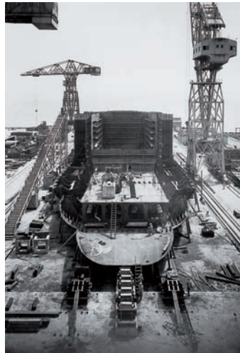
船首より見る （ホールド2重底建て付け終了）
