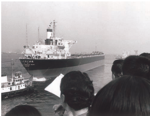
竣工・引き渡し後の見送り風景（昭和45年10月30日）
