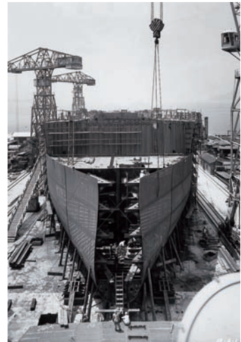
船尾より見る （外板取り付け中）
